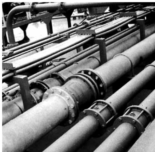
写真2 スリーブタイプ（タンカー）
